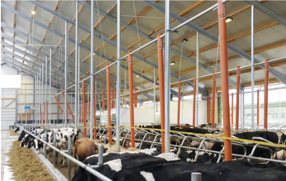
Einstreusystem KFS 100 innerhalb des Stalls
