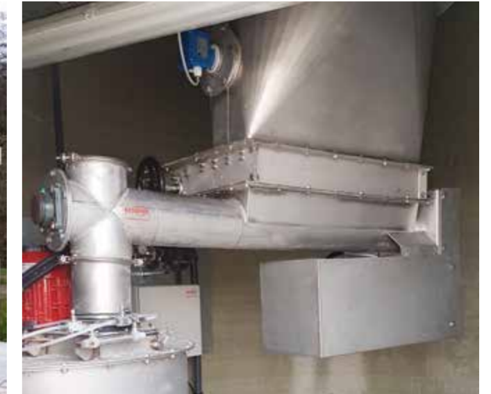
Dosierschnecke mit Absperrschieber aus Edelstahl
