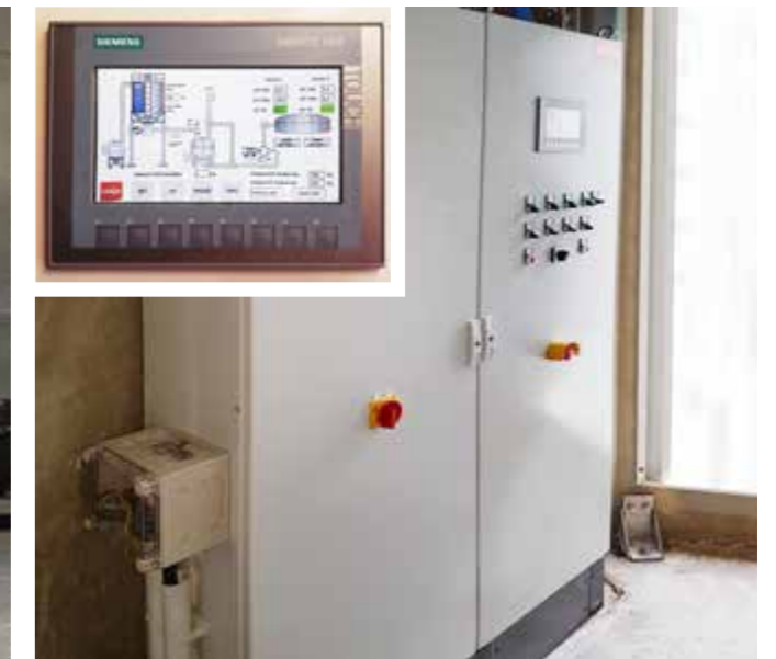
Schaltschrank mit integriertem Touch- Panel
