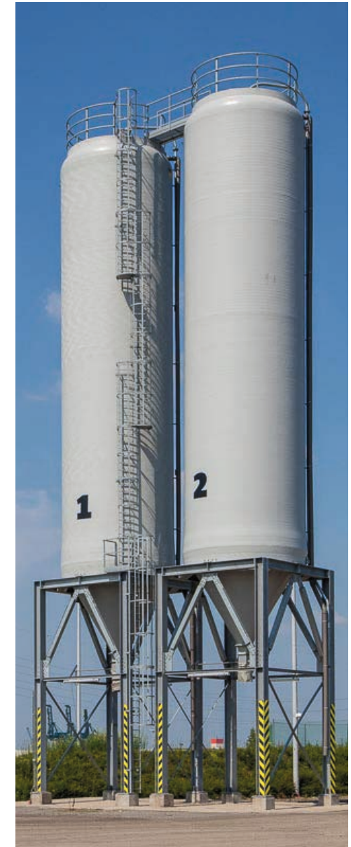
Zwei unterfahrbare Salzsilos mit Steigleiter und Laufsteg
